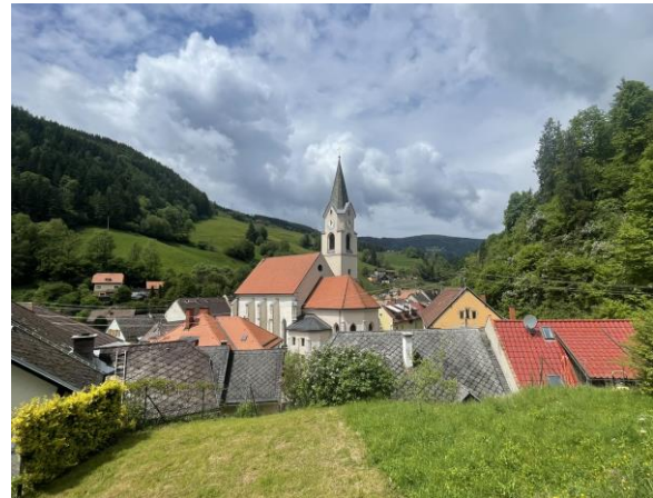
Abbildung 8: Blick auf die Pfarrkirche Hüttenberg Hl. Nikolaus (Quelle: LWK 2025)
